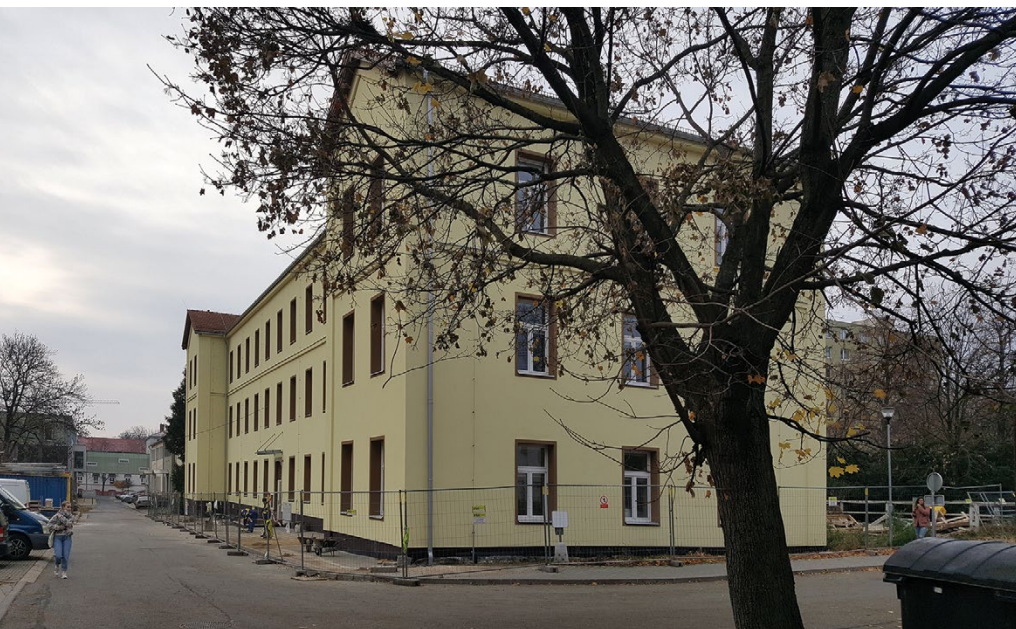
Plán realizace strategického záměru na rok 2022 předpokládá dokončení rekonstrukce budovy určené Ústavu chovu zvířat, výživy zvířat a biochemie
