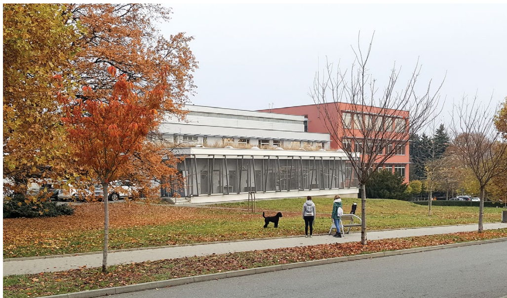
V roce 2022 se Plán realizace strategického záměru soustředí na rekonstrukci Pavilonu klinik malých zvířat
